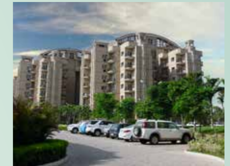
ATS PRELUDE Dera Bassi
